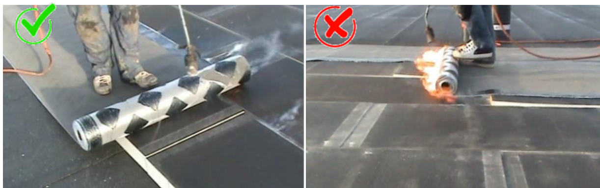
Figuur 8: Aanbrengen met brander op een PIR-isolatieplaat om goede praktijk aan te geven (links: partieel gekleefde basislaag met brander op rol; rechts: brander op isolatieplaat)
